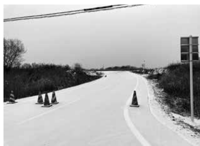
大津地域津波緊急避難場所 避難路
