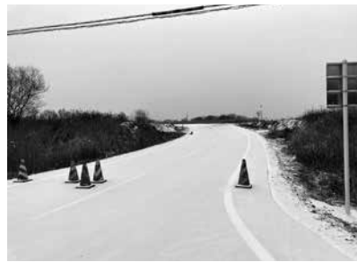
大津地域津波緊急避難場所 避難路
