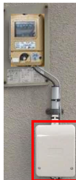
無線通信端末の設置イメージ （既設水道メーター表示器の下部）
